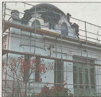
Eingerüstet: Kaiser-Pavillon in Hietzing
